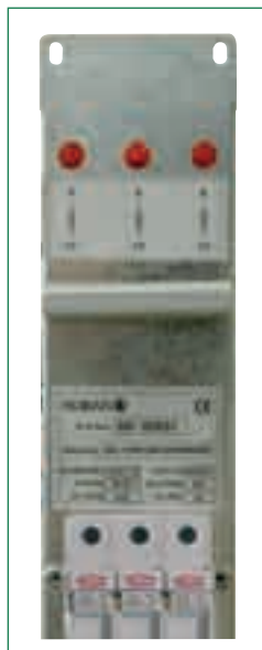
Detalle frontal del módulo MCAP donde se ven los datos de la placa y los LEDS indicadores del estado de los fusibles.
