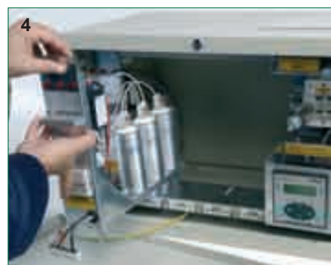
Insert the new module
